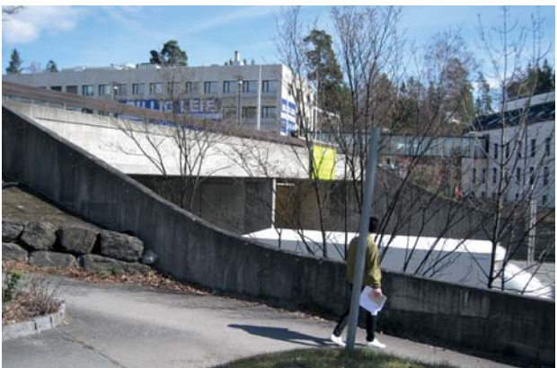
Eksisterende kulvert over Snarøyveien
