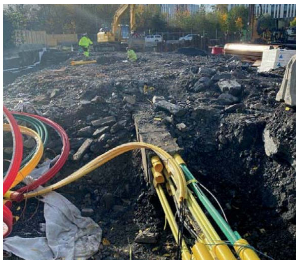
Teknisk infrastruktur i bakken
